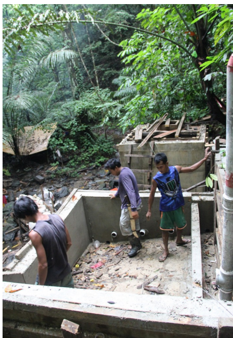
Der Bau des Wasservorratstanks am Bangi-Fluss ist fast abgeschlossen
